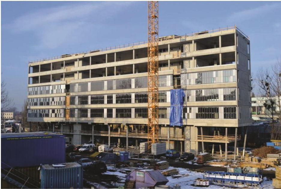
Bild 5: Foto Baustelle ZWT - Bildnachweis: Kessler und Partner GmbH
