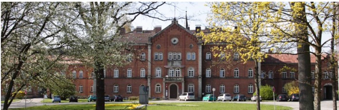
Abbildung 12: Fotoaufnahme: Frontfassade ehemalige Kreisirrenanstalt für Niederbayern, Privat Buchmüller, 22.07.2010
