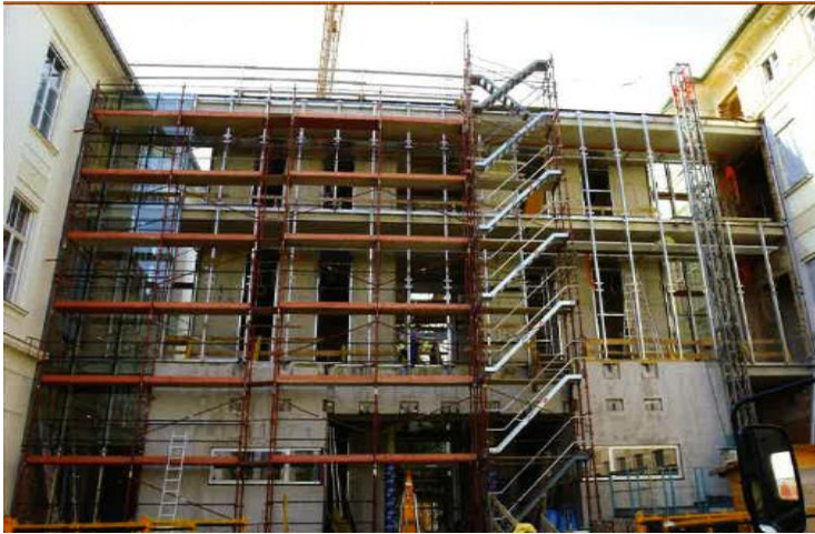
Abbildung 13 - Baustelle Mitteltrakt Quelle: Generalsanierung 2006 Hgg. Technische Direktion KAGes
