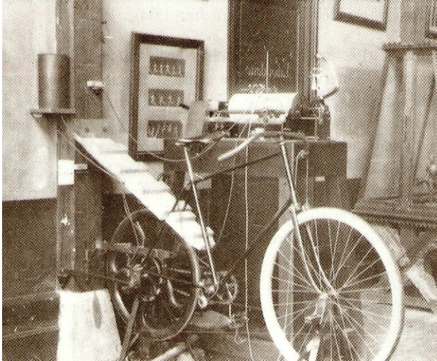
Abbildung 5.: Das erste Fahrradergometer der Welt, entwickelt von Bouny 1896 in Paris (nach Hollmann u. Prinz, 1994) (4)
